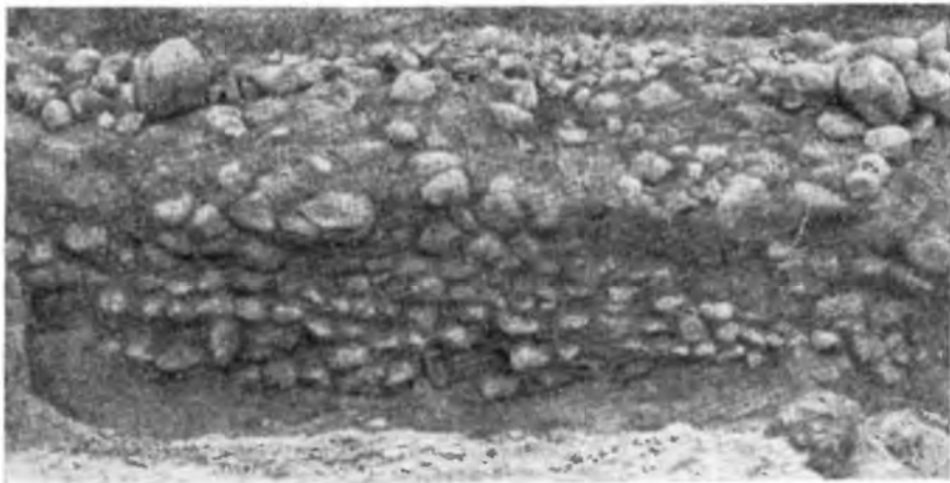
Рис. 3. Фундамент северной стены храма
