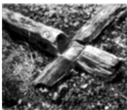
150. Способ рубки угла Южной башни
