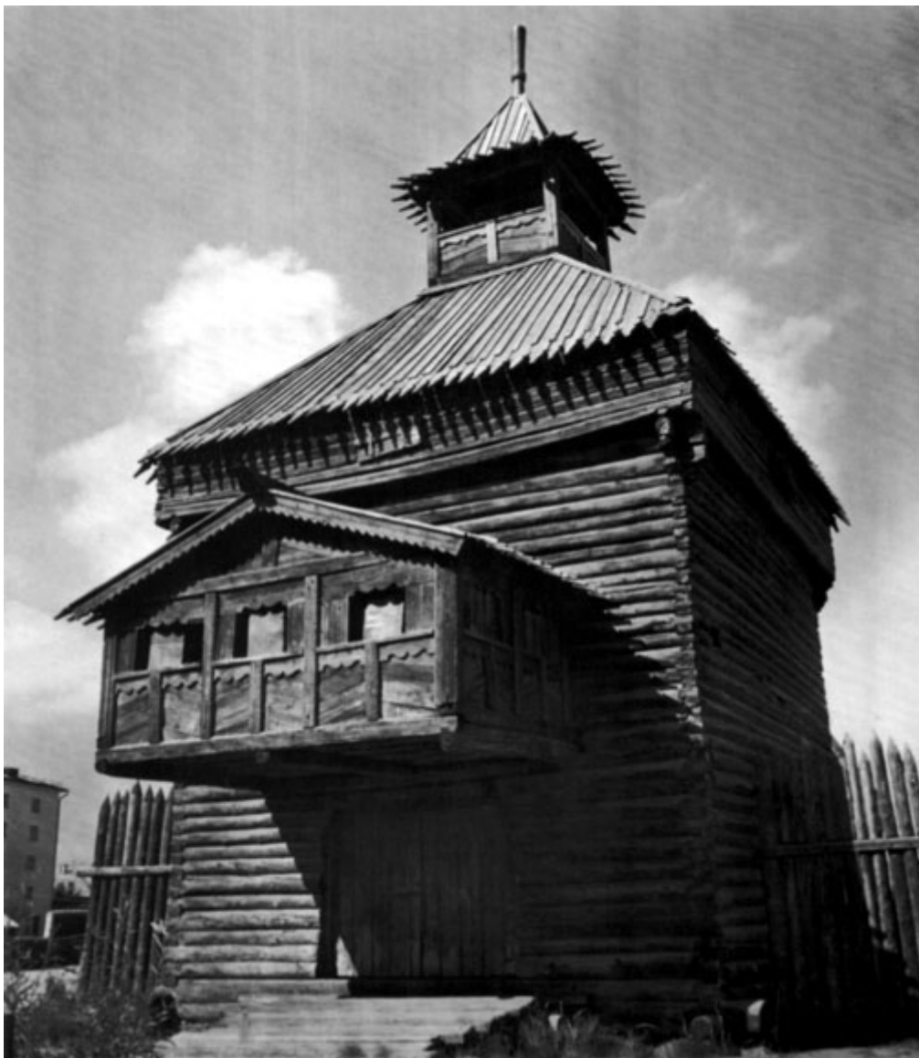
192. Западная проездная башня после реконструкции 1981 г.
