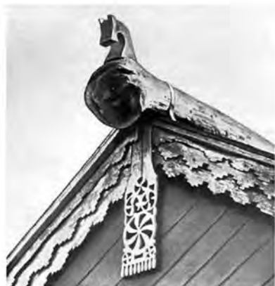
Рис. 82. «ГРОВОМЫЙ ЗНАК» ПОД КОНЬКОМ КРЫШИ. Север
